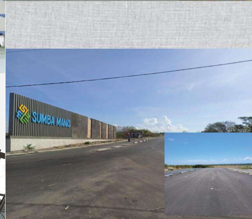
PENGERJAAN JALAN PT. MURIA SUMBA MANIS
